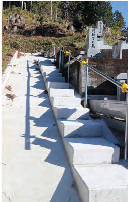
▲ 手すり付コンクリート階段
