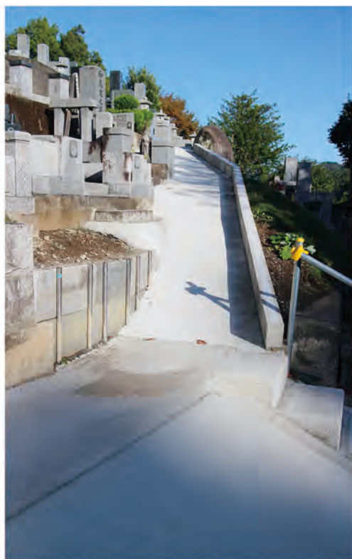
▲ 水路を兼ねたコンクリ舗装
