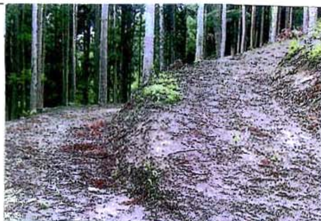
設置された作業道
